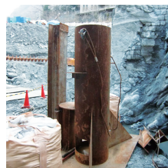
チャッキング用 ケーシング架台
